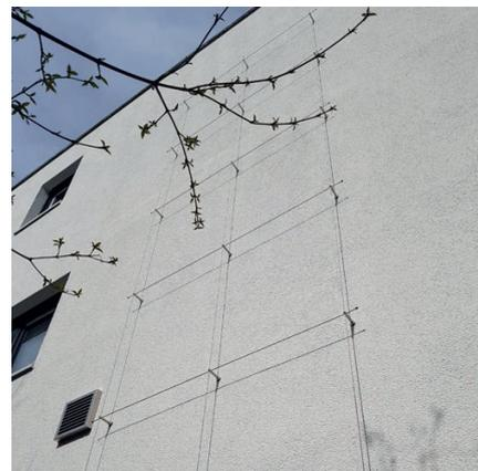
Rasterförmige Seilführung auf Mauerwerkswand
