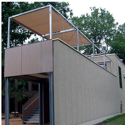
Vertikale Seile auf Mauerwerkswand
