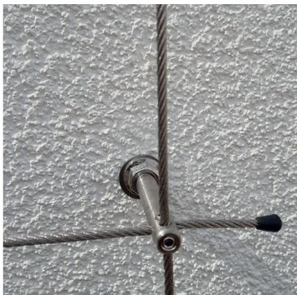
Seile werden einfach mit Klemmschrauben am Halter fixiert
