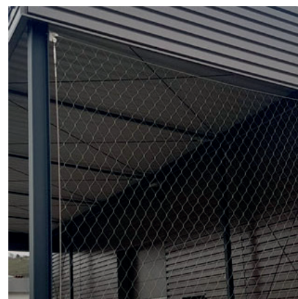
Seilnetz zur Begrünung einer Gewerbehalle mit Kletterpflanzen
